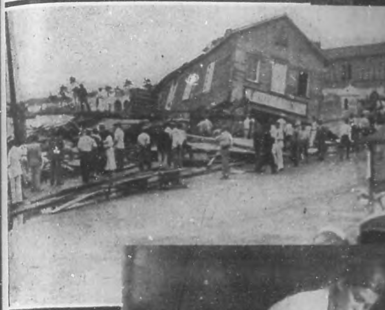
El huracán que devastó a Puerto Rico, produciendo más de dos mil heridos y enormes daños materiales, destruyó la Terminal del Ferry de San Juan, arrojando al mar los restos del edificio.
